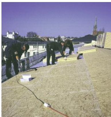
LINITHERM PAL OSB, titanovo-cinkova streha BV, Marstall v občini Schwerin
